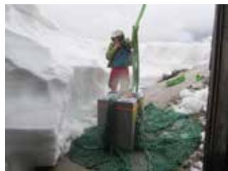
Abflug der alten Batterieanlage
