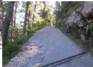
Wasserableitrinnen an der Zufahrt zur Materialeilbahn
