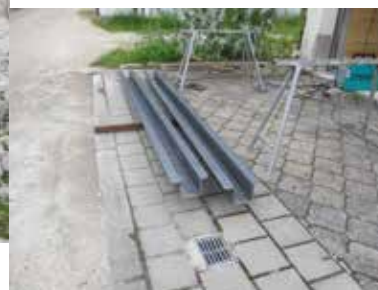
Wasserableitrinnen an der Zufahrt zur Materialeilbahn
