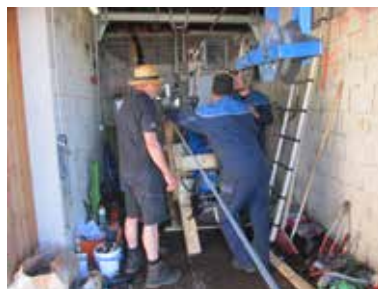
Montage des Neuen Antrieb
