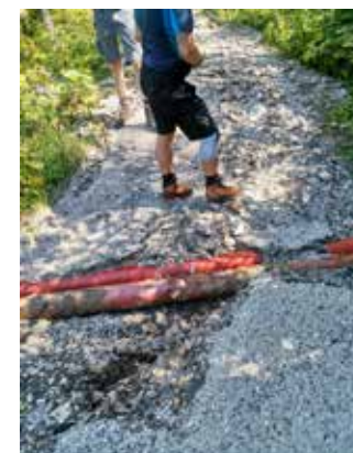
Wasserableitrinnen an der Zufahrt zur Materialeilbahn
